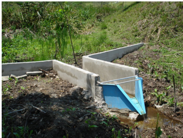
Figura 5 - Calha H instalada para a medição da vazão
