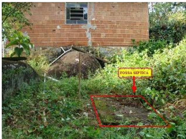
Figura 3. Posição da fossa séptica da residência 1
