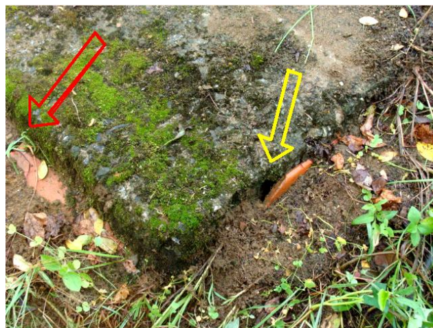
Figura 4. Pequenas aberturas por onde saiam mosquitos voando.
