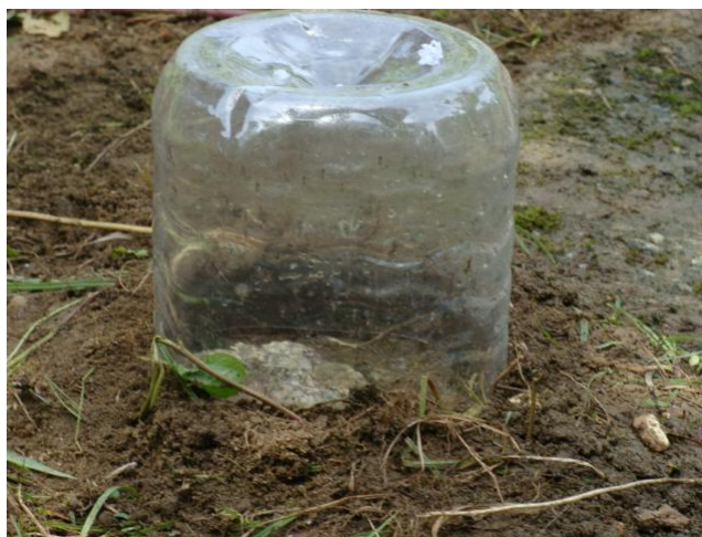
Figura 8. Frasco tampando uma abertura na tampa da fossa.
