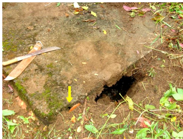
Figura 5. Abertura da figura anterior (seta amarela) e buraco aberto pela caída da terra da beirada, por onde se vê a água.
