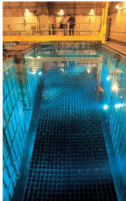
Figura 3. Piscina de água borada para o armazenamento temporário dos Resíduos de Alta Radioatividade
