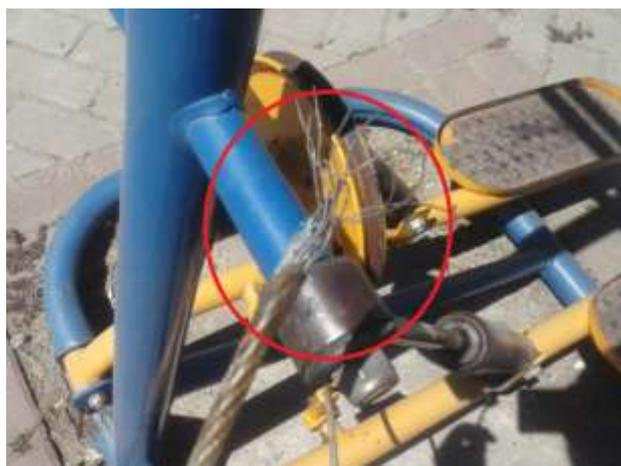
**Figura 6:** Aparelho de ginástica da Praça da Paz – Paraty com o cabo de aço arrebitado.
